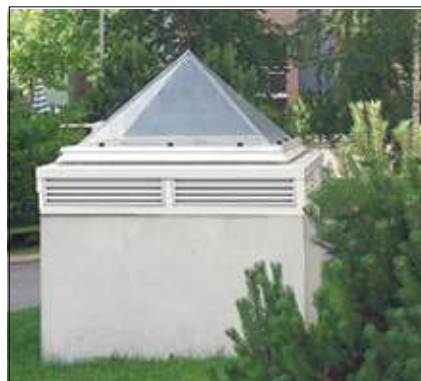
Kupolai tipo PM2N (požeminės perėjos tarp namų apšvietimui ir ventilacijai Lachtis m., Suomija)
